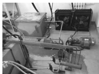
图 3 供油、回油和冷却装置
