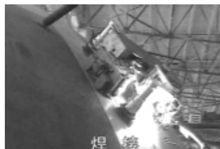
图5 球罐全位置焊接机器人成果样机在现场施焊照片
