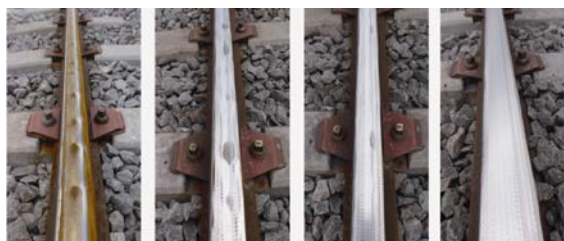
图2 钢轨打磨去除损伤和缺陷演变过程
